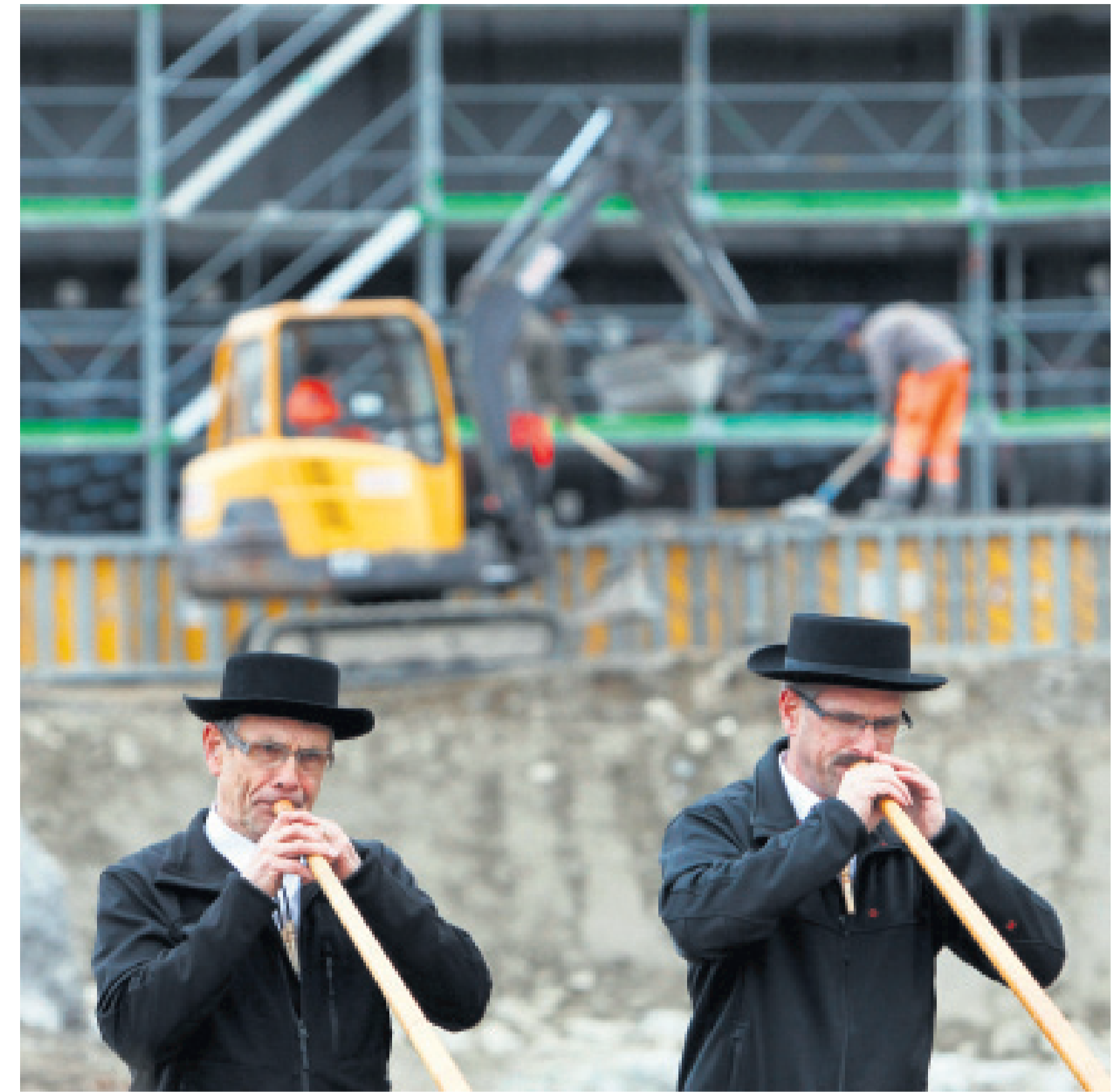
JOUEURS DE COR DES ALPES DANS LE CHANTIER «SWISS ALP RESORT» À ANDERMATT, COMBATTU PAR FRANZ WEBER
